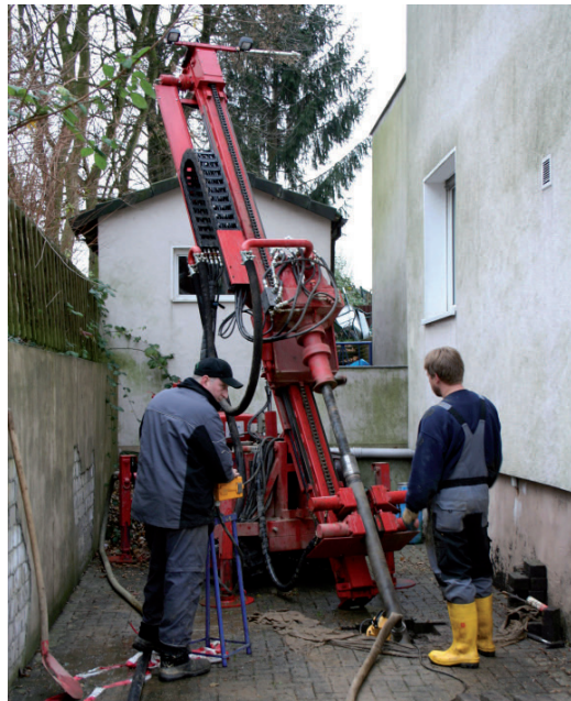
Die GbE Grundbau Essen GmbH übernimmt Baufeldvorbereitung im Spezialtiefbau
