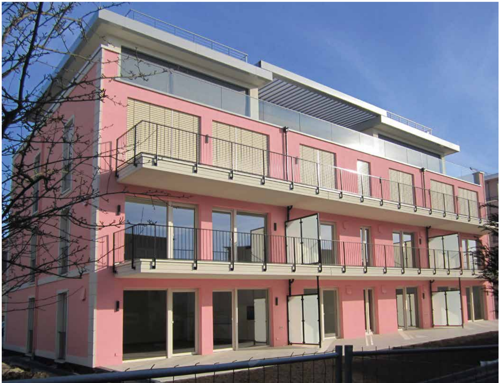
Die Süd-Fassade – Fehlt nur noch der Meeresblick
