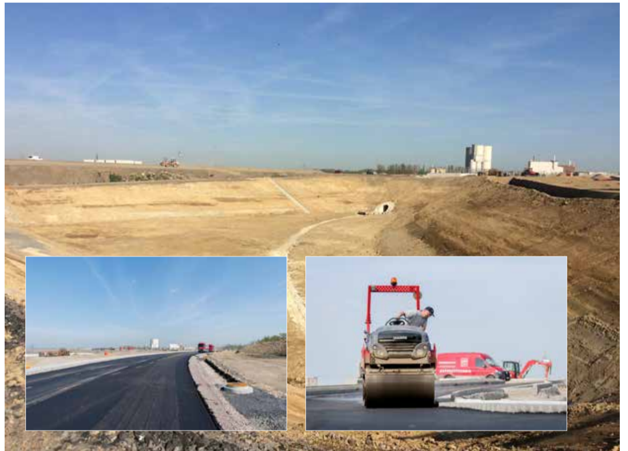
Beginn der Bauarbeiten am Regenrückhaltebecken.
