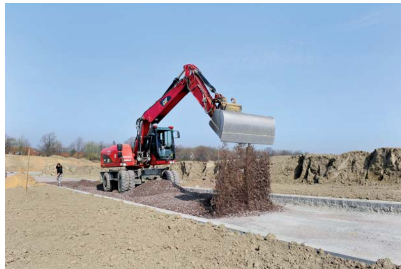
Im Oktober 2011 begann die Gustav Marsch GmbH & Co. KG mit den Bauarbeiten für den 2. Abschnitt im Erschließungsgebiet Iserlohn-Dahlbreite.
