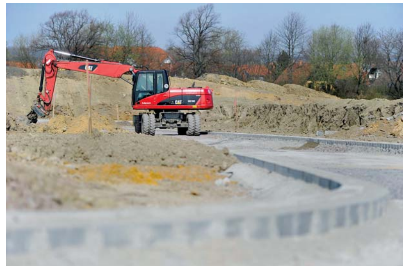
Für den Schotter- und Asphalteinbau werden jeweils 15.000 to. Material verbaut bzw. 10.000 m 2 Asphalt eingebaut.
