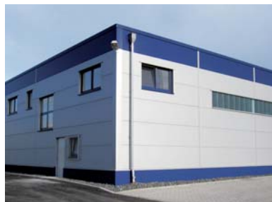
Die Tief- und Erdbauarbeiten führte die Gustav Marsch GmbH & Co. KG aus.
