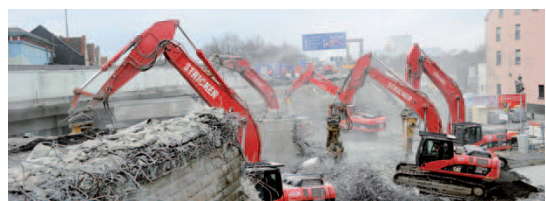
Um den südlichen Teil der A40-Überbauung abzutragen, mussten in Tag- und Nachtschicht rund 2.100 Tonnen Baumaterial abgebrochen und abgefahren werden.
