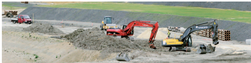
Die Erd-, Kanal und Straßenbauarbeiten für den Zukunftsstandort PHOENIX starteten im Juli 2009.
