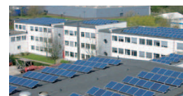
Seit 2009 in Betrieb: die neue Photovoltaik-Anlage
